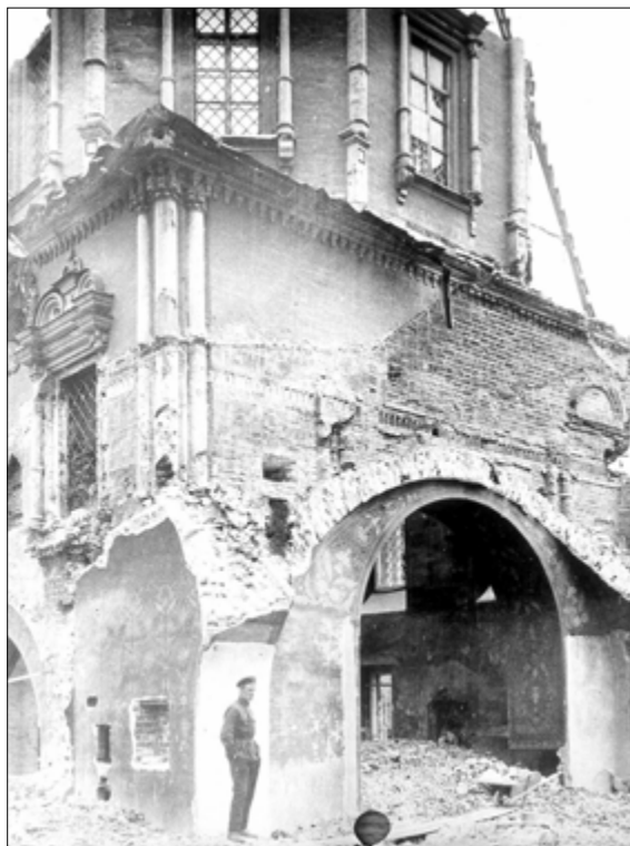
Церковь Трех Святителей в процессе разборки в 1928 г., вид с северо-запада
