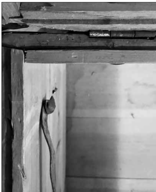
Рис. 6. Соединение стенок сундука в мануфактурной конструкции. Вторая половина XIX в., Средний Урал. ОНИ ГРМ. Инв. № М-1128. Фотография Г.А. Пудова
